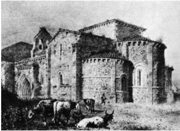
FIGURA 23. San Antolín de Bedón, reedificada en 1176, según el modelo basilical de Frómista, pero cubierta con bóvedas y arcos fajones apuntados.
